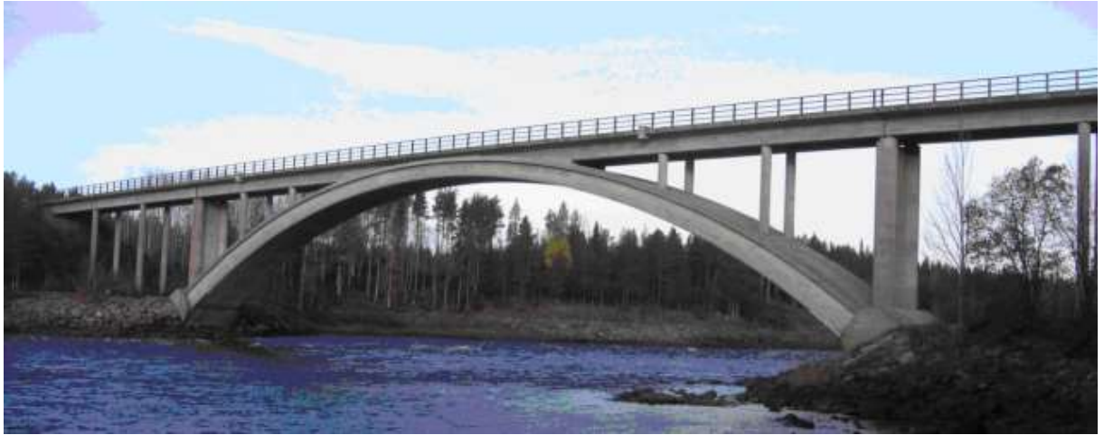
Figur 3.4 Järnvägsbron vid Långforsen över Kalix älv bygd 1960. Bågen har 87 m fri spannvidd.
