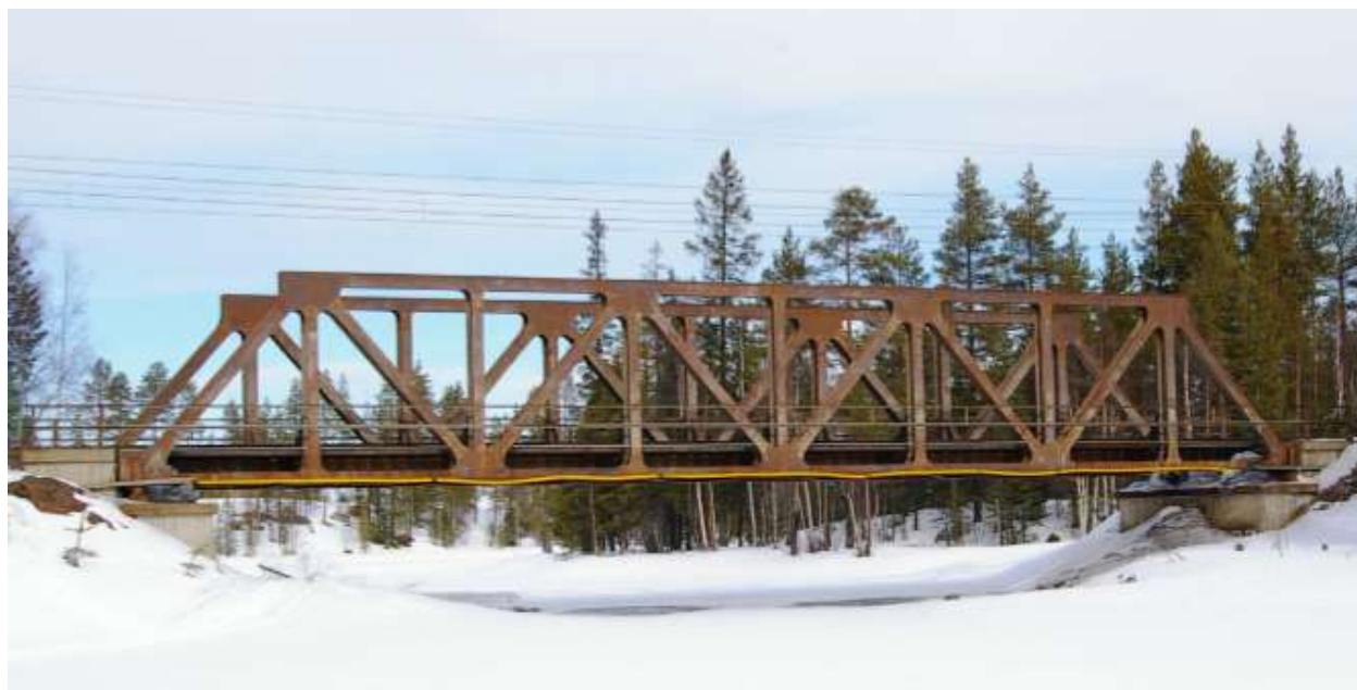
Figur 3.5. Järnvägsbron över Åby älv från 1955. (Foto Thomas Blanksvärd)
